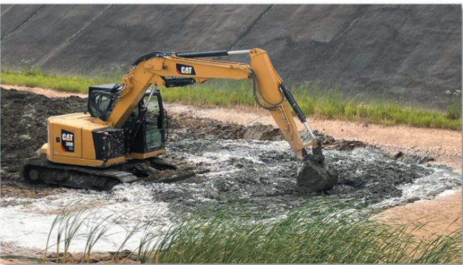
浚渫工事における施工の様子
