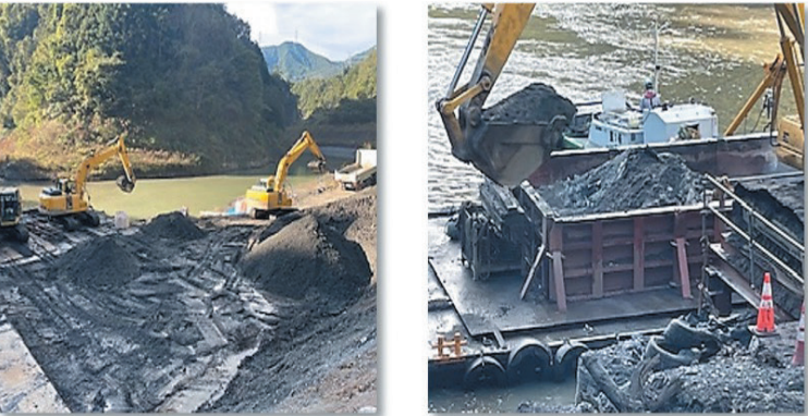
ダム浚渫工事における施工の様子
