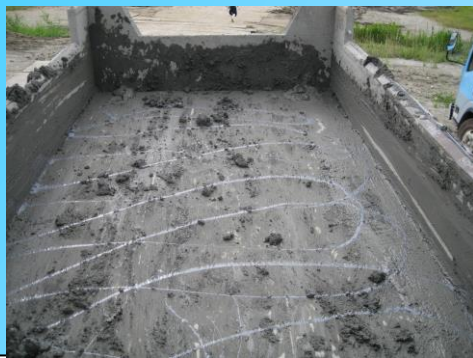
ダンプ荷台にマッドスベールLを適量散布
