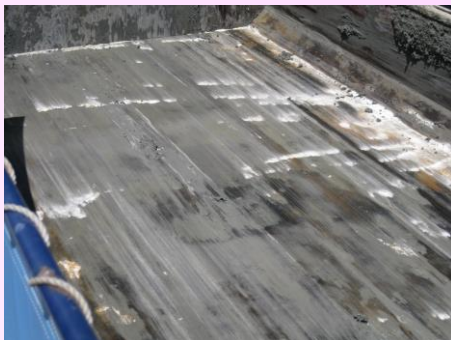
土砂荷降ろし後 土砂の付着無し
