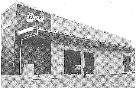
施設は新規で設置している
