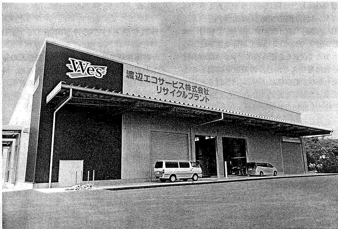
新プラント外観
