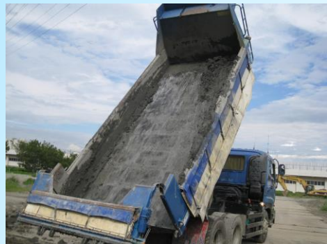
土砂荷降ろし後 土砂の付着無し
